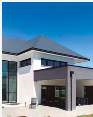
Een huis van 610 m 2 met vloerverwarming en sanitair warm water in Saint-Prest (Frankrijk). Aquarea
